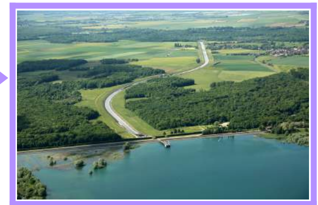
Barrage-réservoir Marne (Source : EPTB Seine Grands Lacs)
