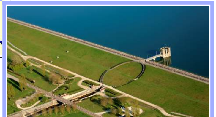
Barrage-réservoir Aube (Source : EPTB Seine Grands Lacs)
