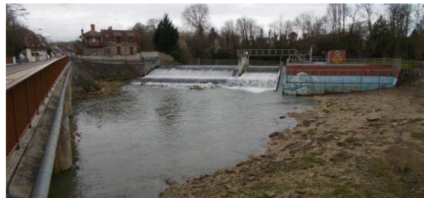
Déversoir de Saint-Julien-les-Villas (Source : TCM)
