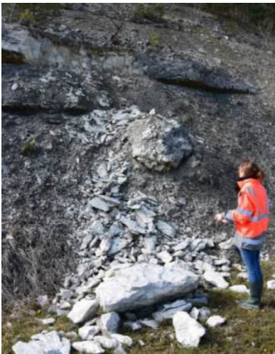
Chute de blocs à Bar-sur-Aube (Source : BRGM)
